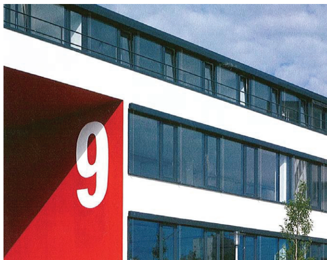
Sitz der Genossenschaft im Gewerbehof am Westpark in München-Sendling, Adi-Maislinger-Straße 9
