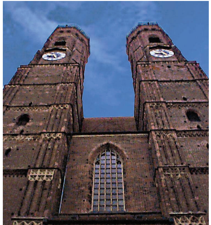
Im Liebfrauentum München („Frauenkirche“) hat die igmuc Ende der 1990-er Jahre an den Reparatur-, Umbau- und Sanierungsarbeiten mitgewirkt, so etwa an den Entwurfs- und Ausführungsplanungen, der Gebäudeautomation, der Lichttechnik und Sicherheitstechnik.
